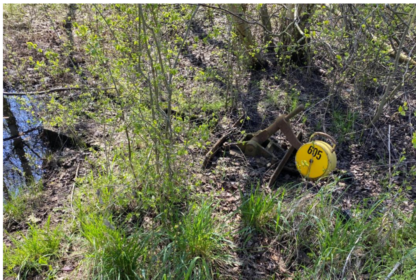
Figur 14-4. viser et sporskifte og det tilgroede jernbanespor. Tilstanden af skinner og bevoksningen viser, at banen ikke har været benyttet i mange år.
