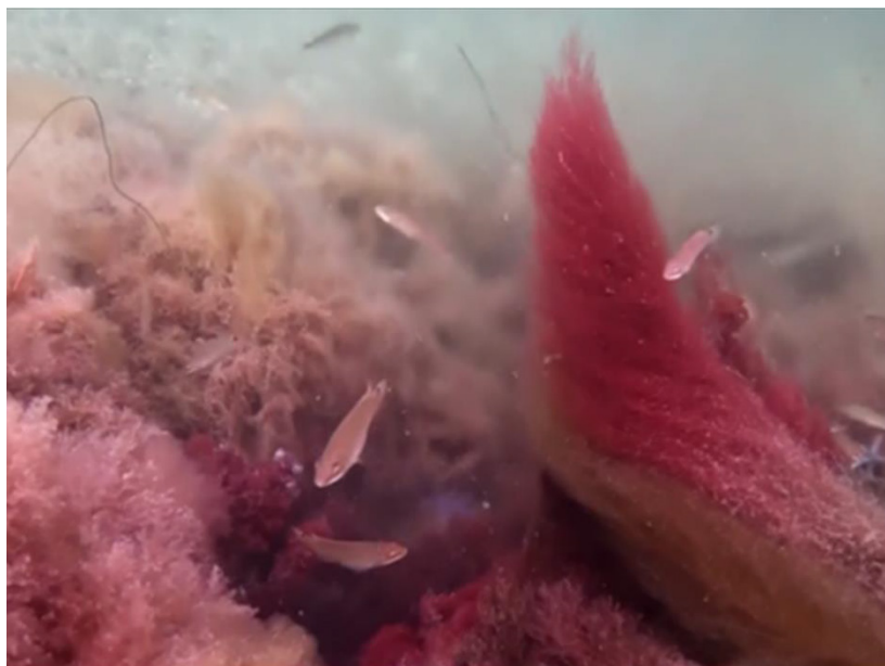
Figur 14-6. Overfladen af den eksisterende havledning lige ved en udledningsdysse. Ledningens overflade er bevoxet med alger, men fremstår i god stand, og vil ikke blive skiftet som en del af projektet.
